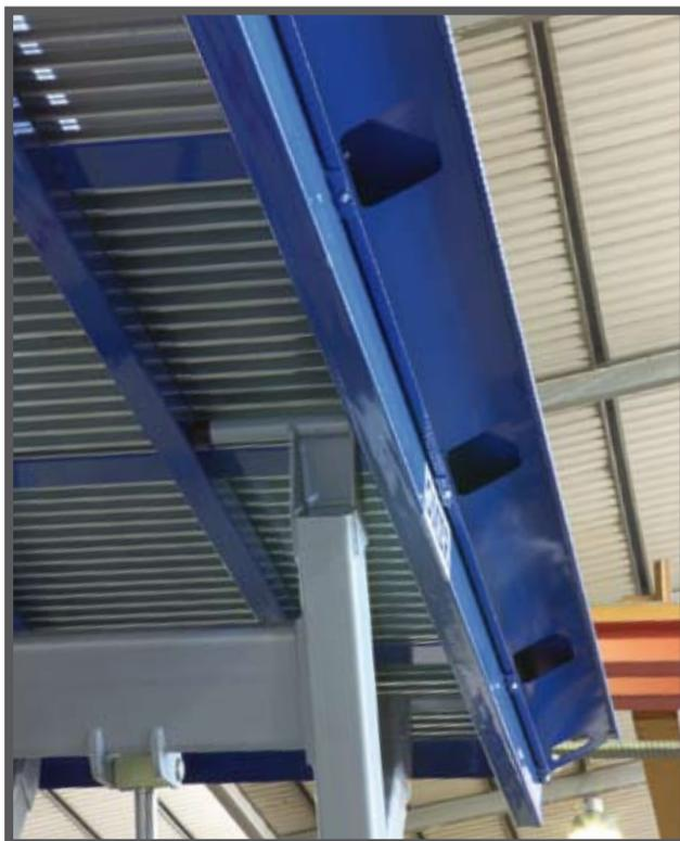
Le dessous de la plateforme est dotée d'une ossature en acier, qui en assure sa fiabilité.
