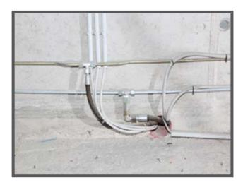
La photo détaillée du raccordement électrique et hydraulique placé au centre des deux colonnes, situé au-dessous de la plateforme, dans la fosse de la gaine, illustre la simplicité de l'installation.
