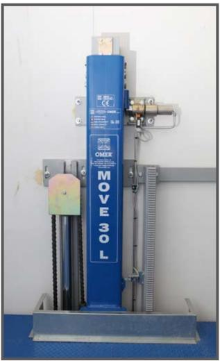
Sur l'ensemble de ces photos figure le taquet de charge de la plateforme du niveau, avec l'actionnement hydraulique.
