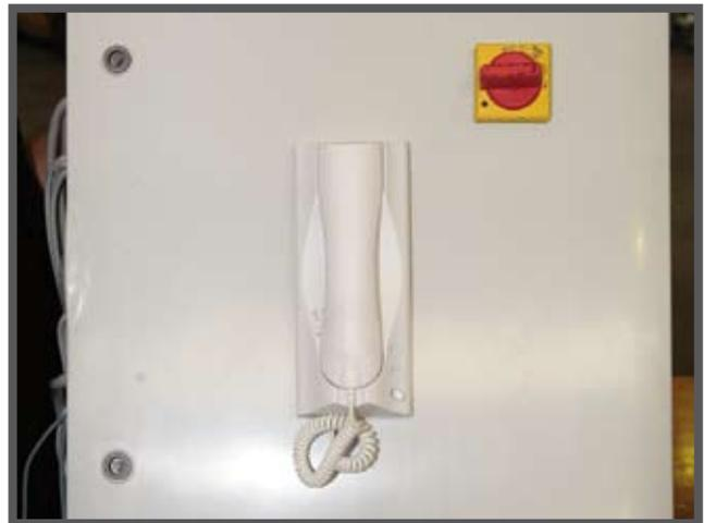
Tableau électrique de commande habituellement installé sur le mur situé au-dessus du groupe hydraulique. La photo détaillée montre le récepteur acoustique qui relie l'interphone situé à bord de la plateforme.
